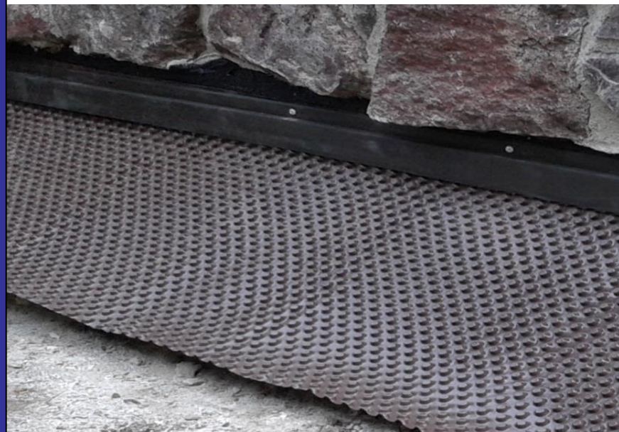
Grundmauerschutz V.V.K.-Objekt Uhdestr. 40
